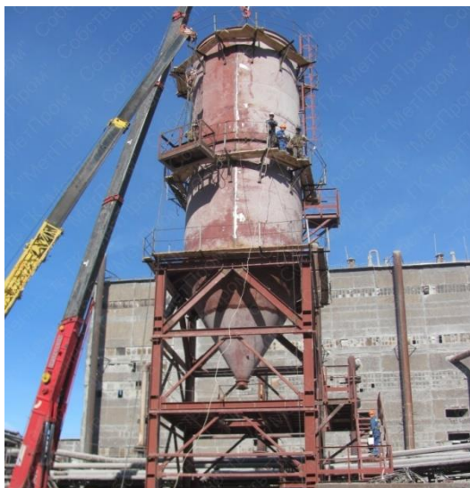
Рис. 3. Шахтная печь
