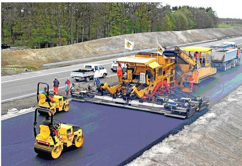
Рис. 5.1. Укладка асфальтобетонной смеси на всю ширину проезжей части
