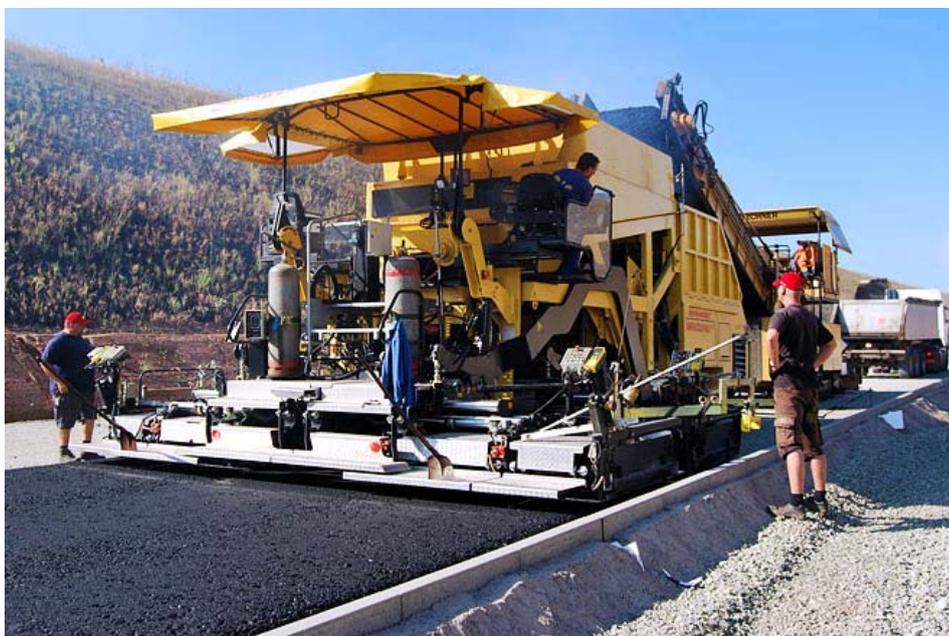
*Рис. 1.2. Одновременная укладка двух слоев асфальтобетонного покрытия с помощью комбинированного асфальтоукладчика*
