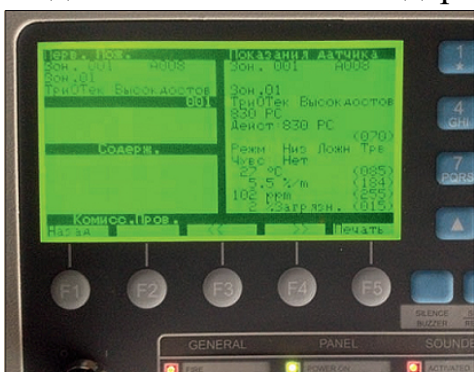
Рис. 1. Аналоговые величины дымового-СО-теплого адресно-аналогового извещателя
