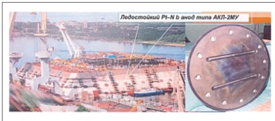
РИСУНОК 31 | Изготовленные по нанотехнологии металлокомпозитные платино-ниобиевые ледостойкие аноды с текстурированным Pt покрытием на подводной части кессона нефтегазодобывающей платформы «Приразломная».
