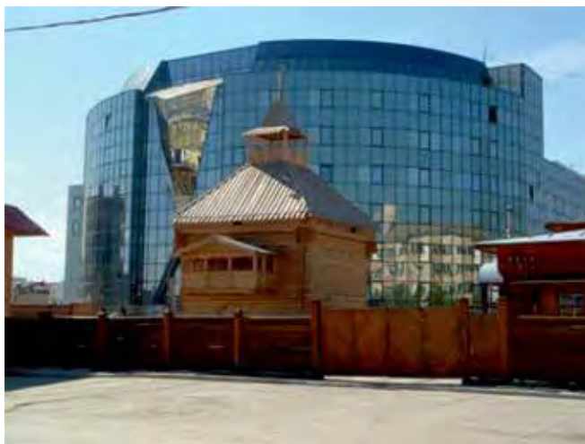
Рис. 11. Башня Якутского острога после реставрации
