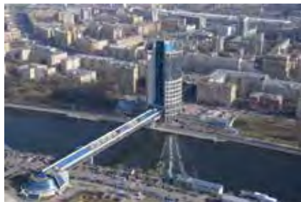
Рис. 5. Мост «Багратион» и «Башня 2000»
