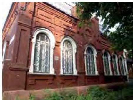
Рис. 4. Здание дворянского поземельного банка
