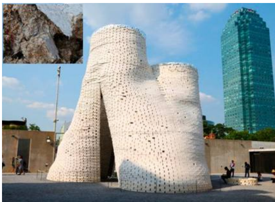
Рисунок 6. Новый стройматериал - дом из грибов
