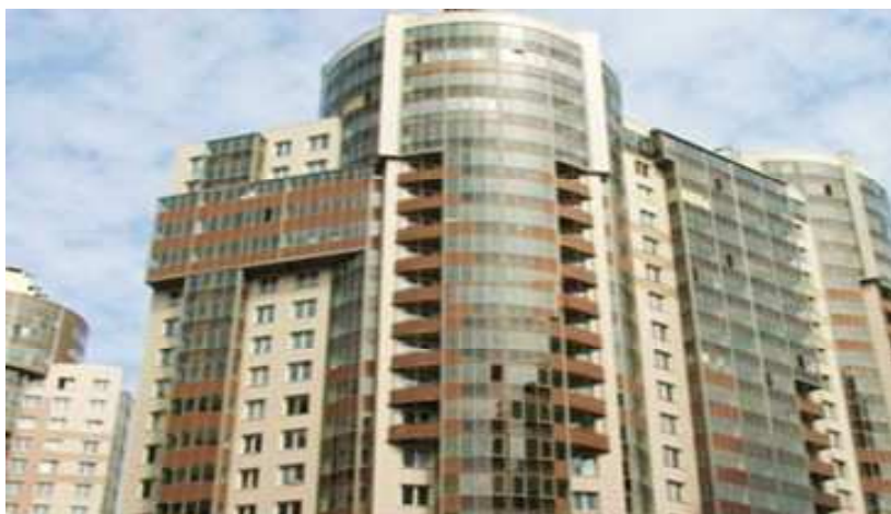
Рис. 17. Многоэтажный монолитный дом в Сочи
