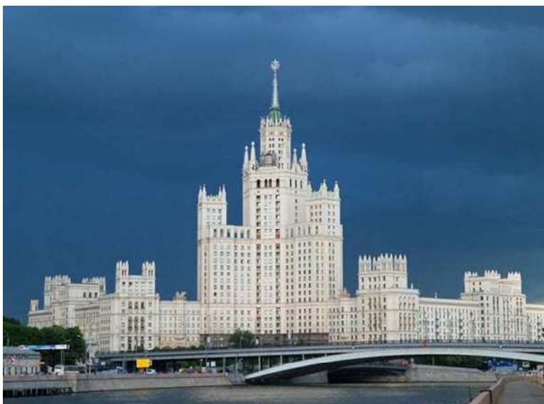
Рис. 10. Высотное здание на Котельнической набережной в Москве
