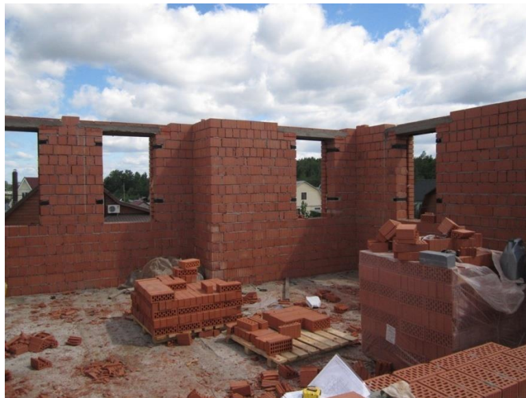
Железобетонные перемычки в кирпичном здании
