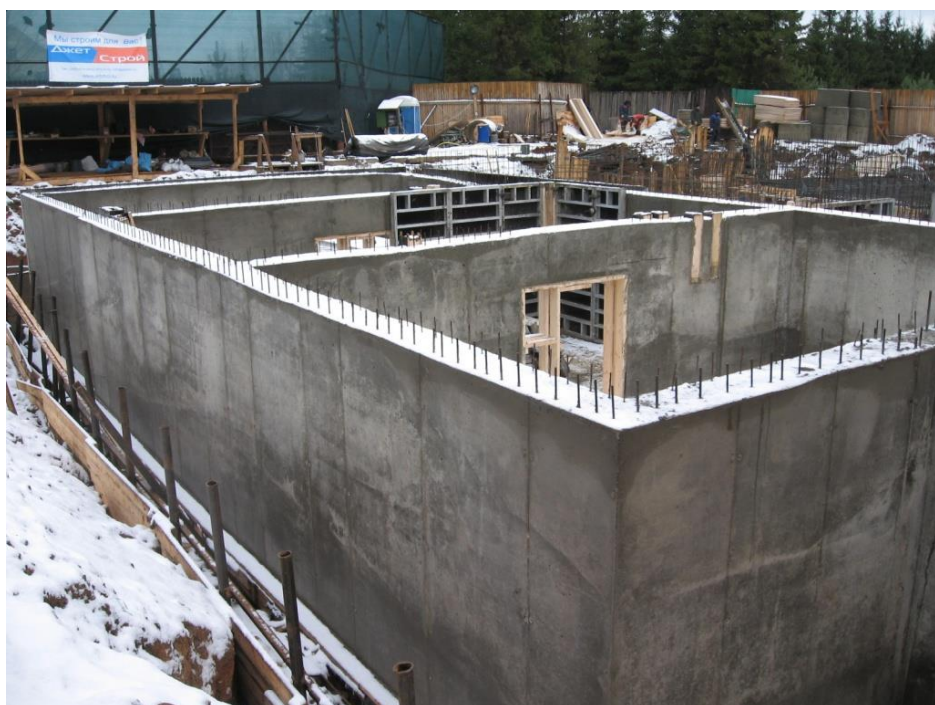
Монолитная стена из легкого бетона
