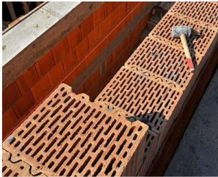
Кирпичная стена с воздушной прослойкой
