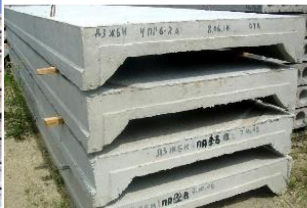
Рёбристые железобетонные панели перекрытий
