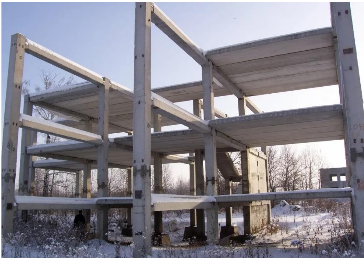
Перекрытие по сборным железобетонным балкам:
