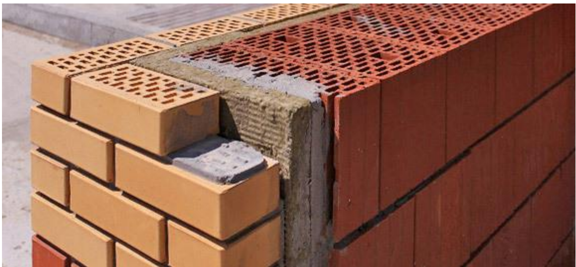
Кирпичная стена (основной материал из стенового кирпича и облицовка лицевым кирпичом)
