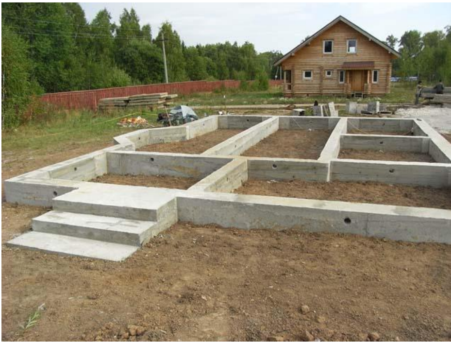
Ленточный фундамент под ИЖД
