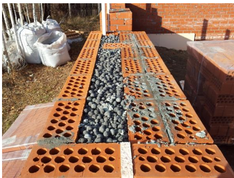
Утепление кирпичной стены керамзитом
