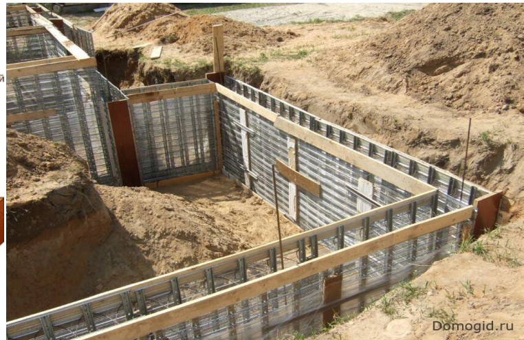
Опалубка для изготовления ленточного монолитного фундамента
