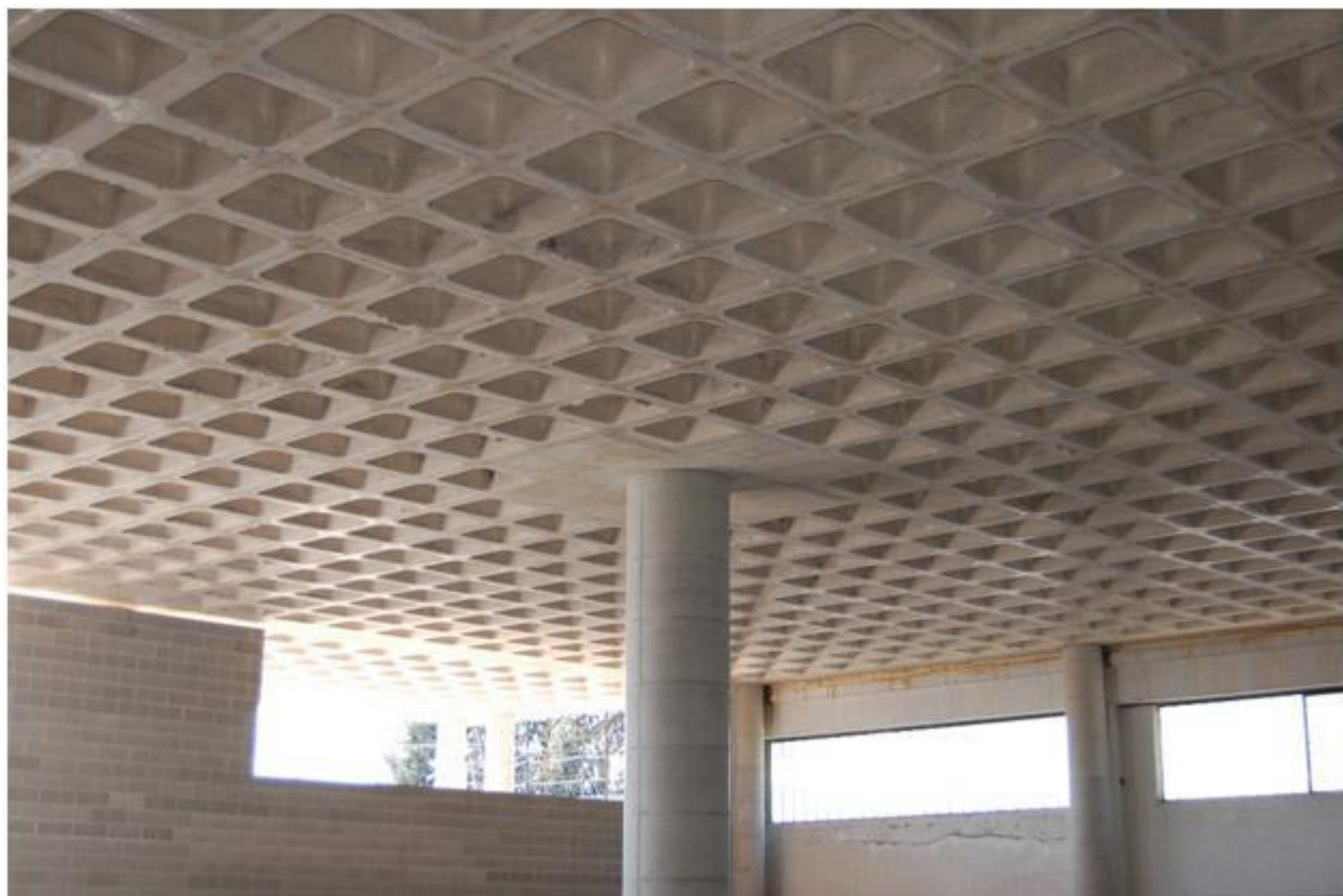
Монолитное кессонное перекрытие
