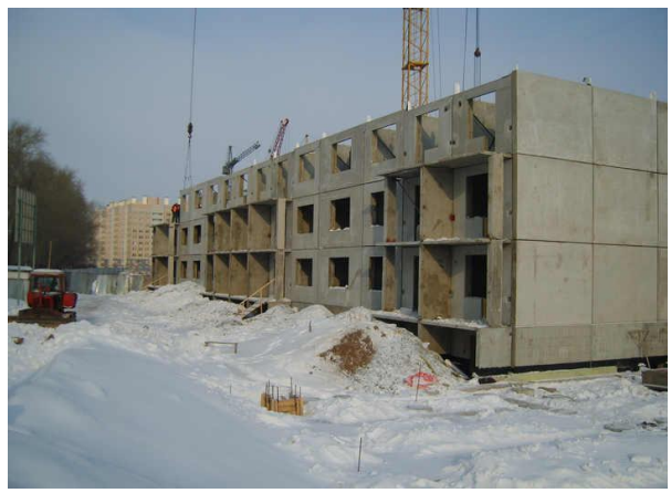
Монтаж панельного дома
