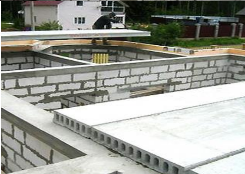
Установка плит перекрытий
