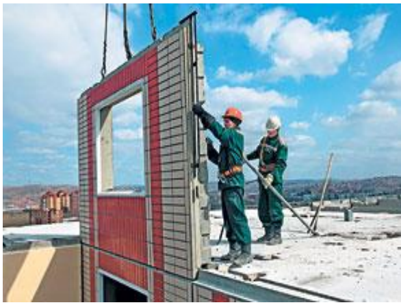
Монтаж панельного дома
