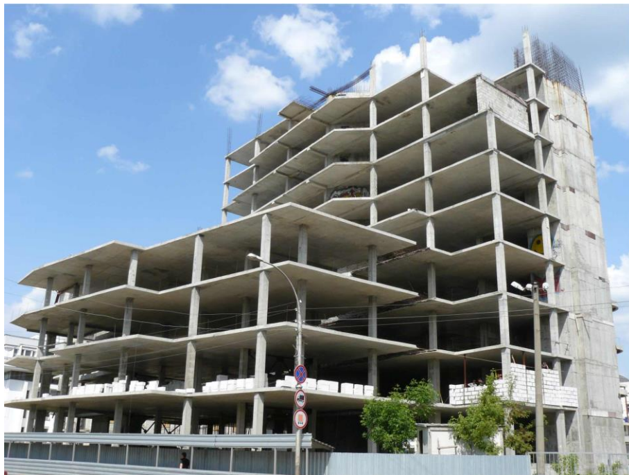
Монолитный железобетонный каркас многоэтажного здания
