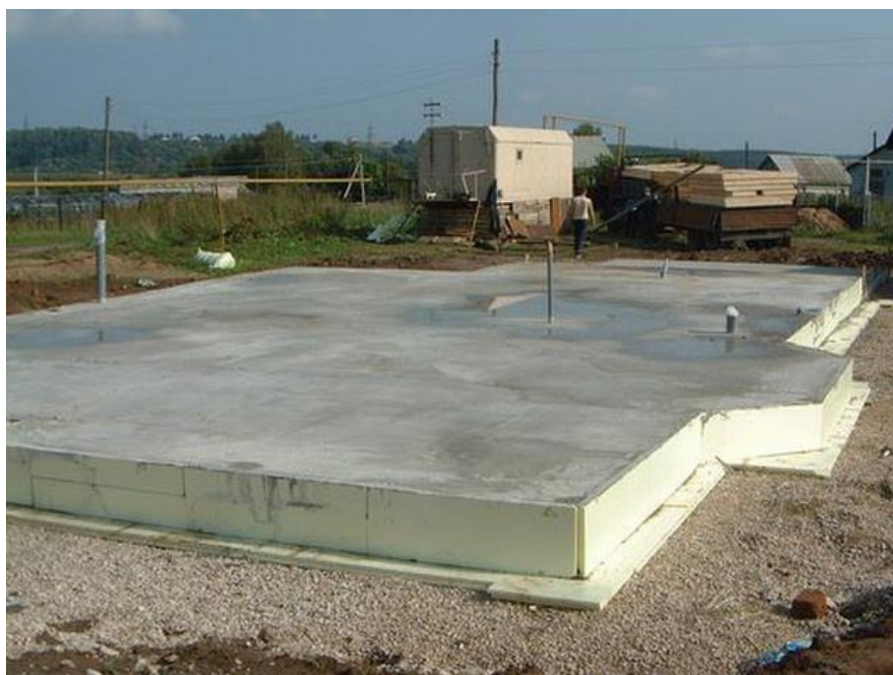
Плитный фундамент под ИЖД
