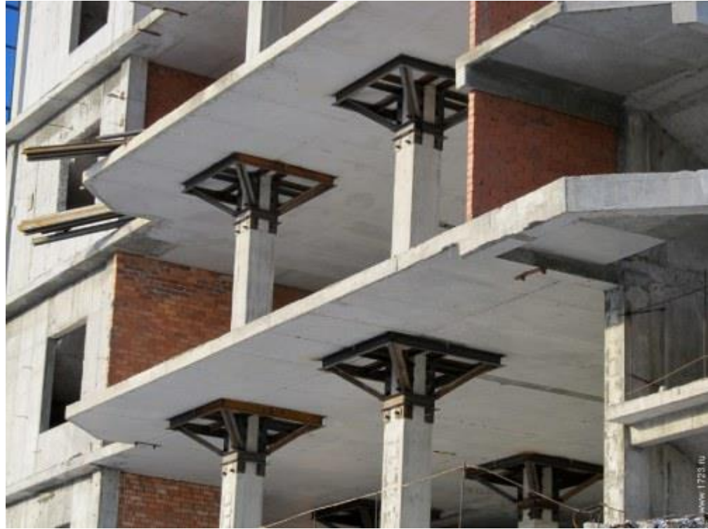
Безбалочное монолитное железобетонное перекрытие
