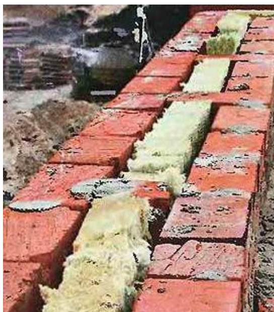
Утепление кирпичной стены термовкладышами
