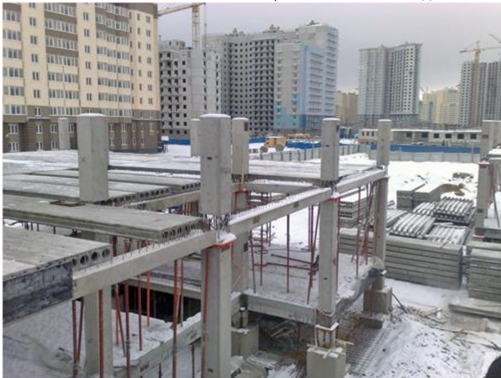
Сборно-монолитный каркас из железобетонных элементов многоэтажного здания
