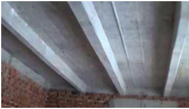
Рёбристое монолитное железобетонное перекрытие
