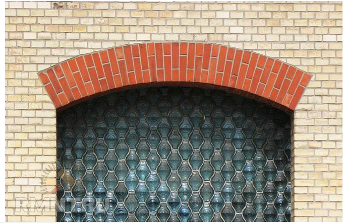
Лучковая (арочная) перемычка
