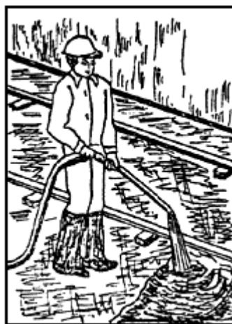
Рис.5. Нанесение раствора соплом при устройстве полимерцементных стяжек
