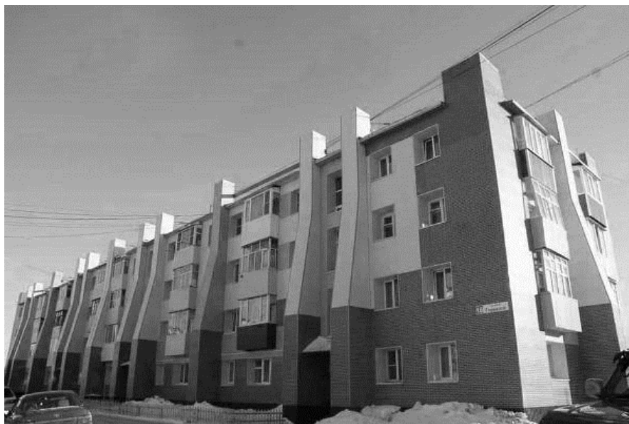
Рис. 18.2. Сейсмоусиление дома путем устройства аппликаций и контрфорсов из монолитного железобетона
