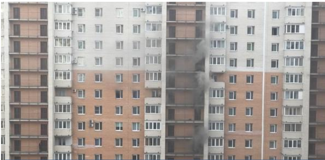
Рис. 1 Жилой дом пр. Коломяжский, 15к2. 28.03.2018. Заявка – «...горит электрощит на 23 этаже». Не сработала система дымоудаления.
