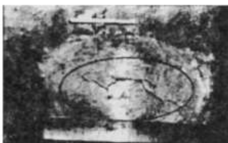
Рис. 1.18. Паукообразные трещины
